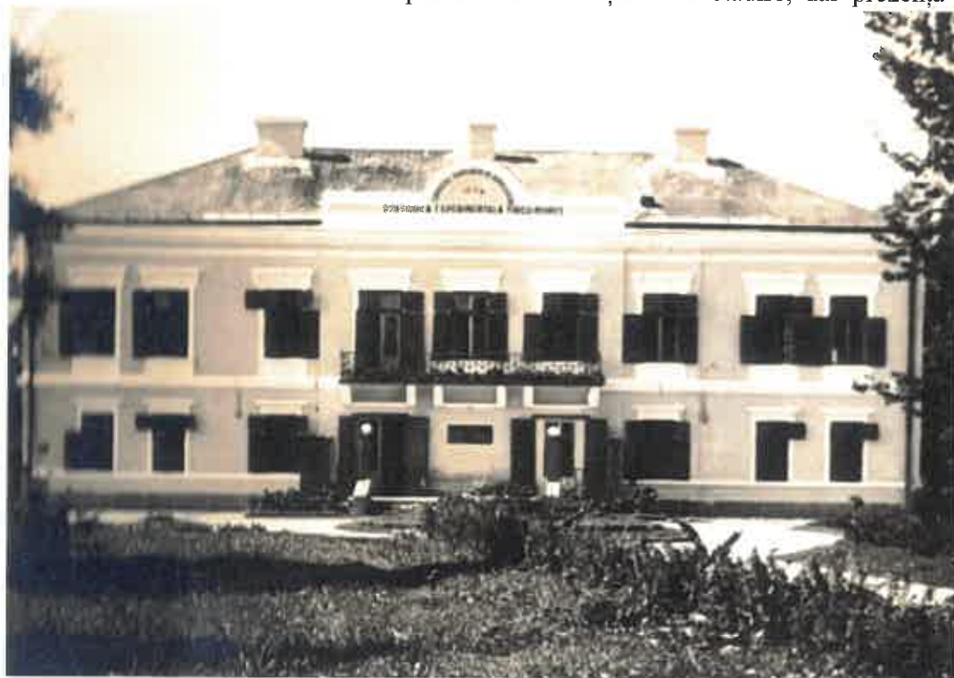
Castelul Máriaffi a găzduit pentru circa 2 ani, Postul de Jandarmi Sângeorgiu de Mureș, înainte de transformarea lui în sediu a Stațiunii Experimentale
